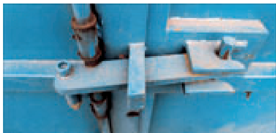
SCR System Centralnego Ryglowania w pozycji zamkniętej
